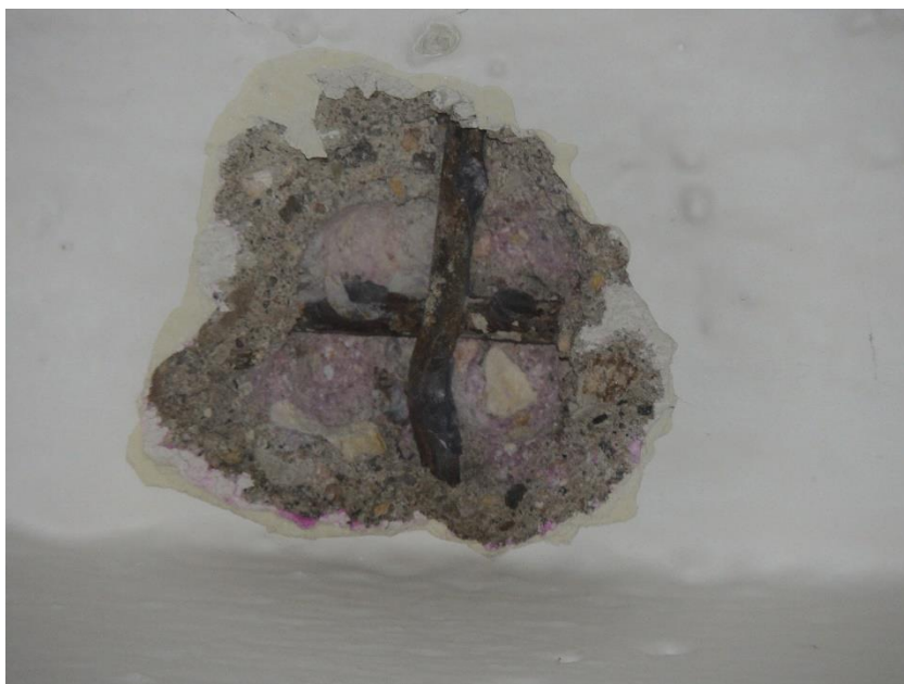
Detail sondy k výztuži desky stropní konstrukce
