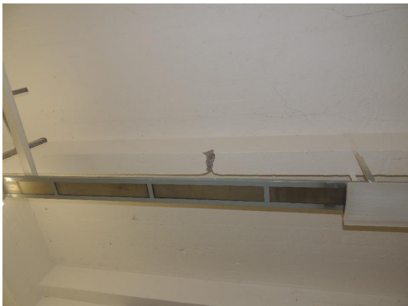
Ověření výztuže trámu stropní konstrukce v jiném poli mezi průvlaky
