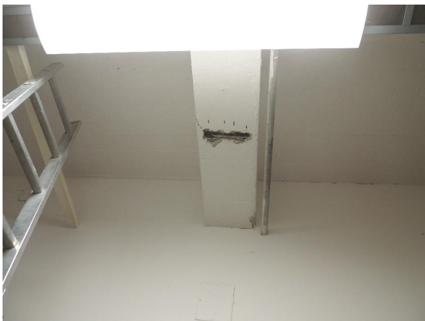
Sonda k výztuži průvlaku stropní konstrukce
