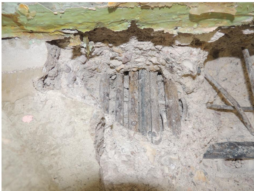
Nalezená horní výztuž trámu stropní konstrukce
