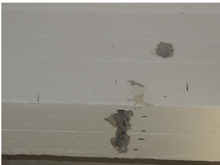
Hledání druhé vrstvy výztuže průvlaku stropní konstrukce
