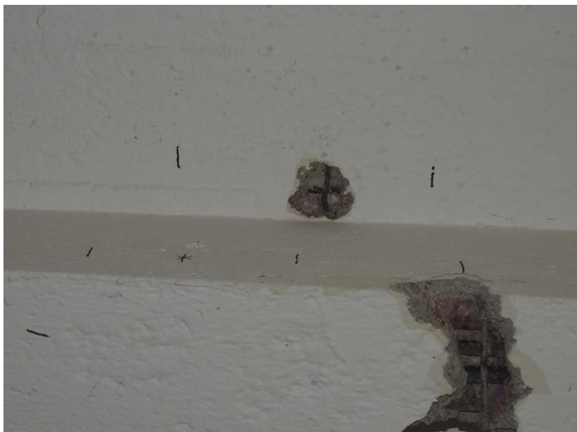
Sonda k výztuži desky stropní konstrukce
