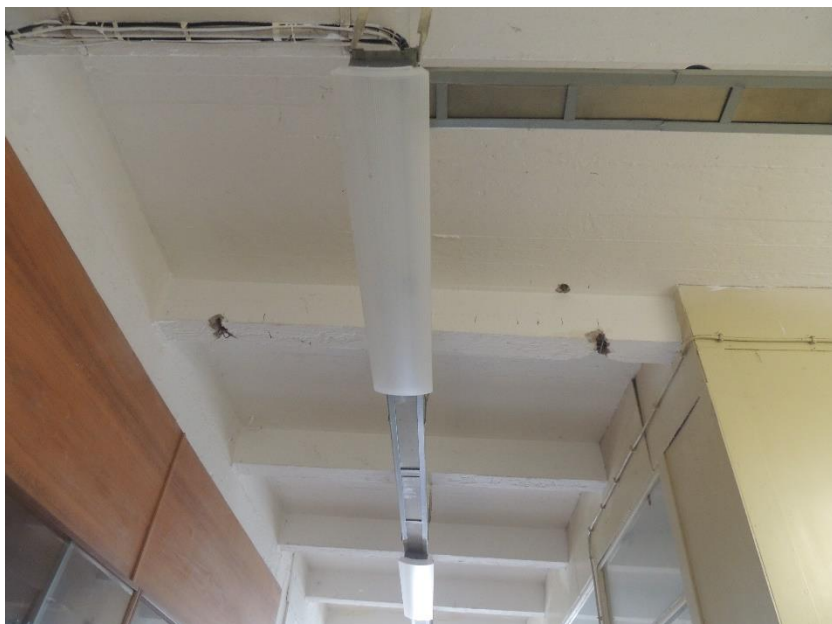
Sonda k výztuži trámu stropní konstrukce
