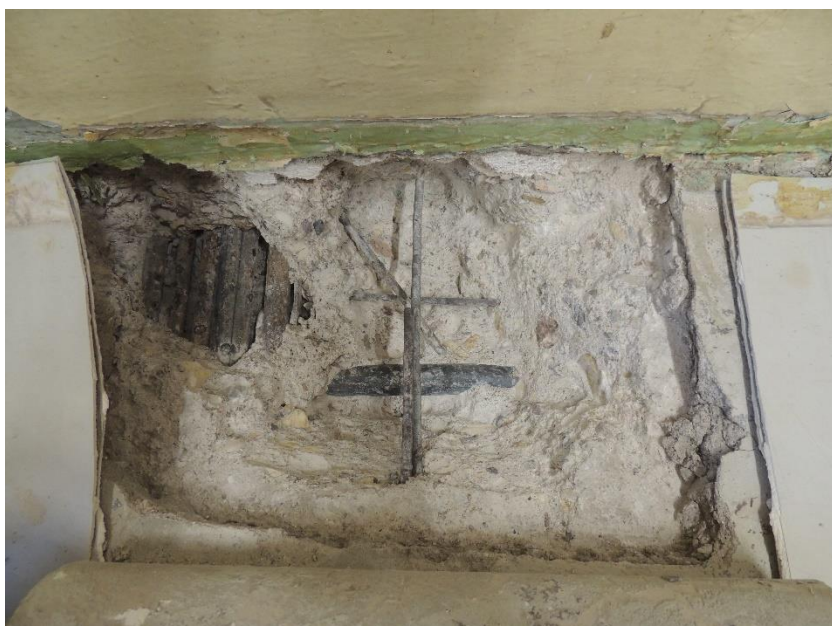
Sonda k výztuži trámu, desky a průvlaku stropní konstrukce z horního líce přes podlahové vrstvy
