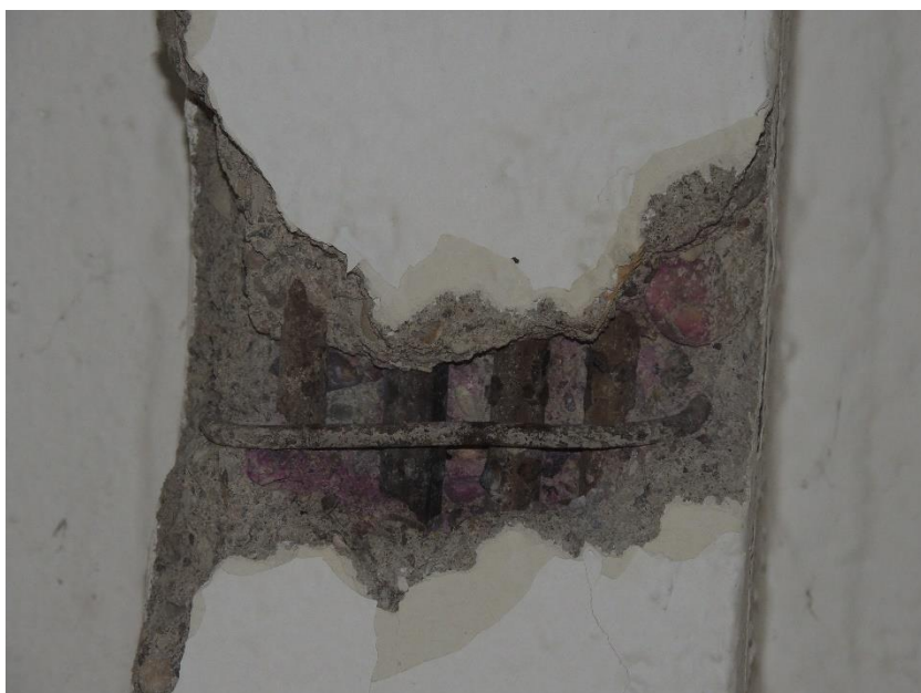
Sonda k výztuži trámu stropní konstrukce v poli mezi průvlaky
