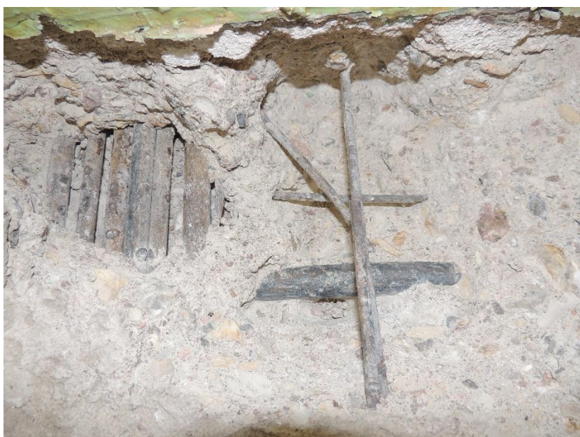
Nalezená horní výztuž desky a průvlaku stropní konstrukce
