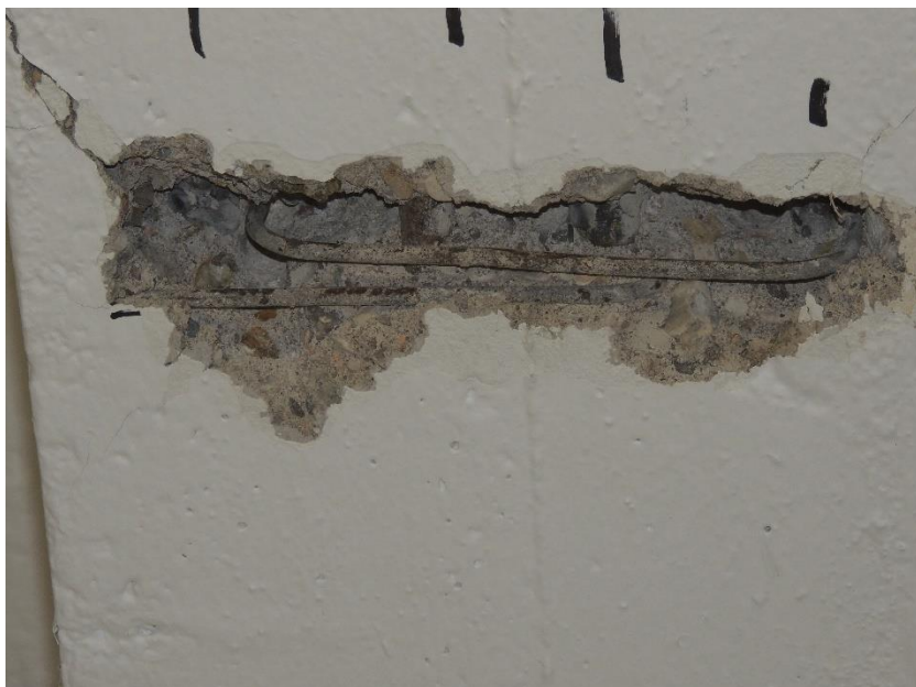
Detail sondy k výztuži průvlaku stropní konstrukce
